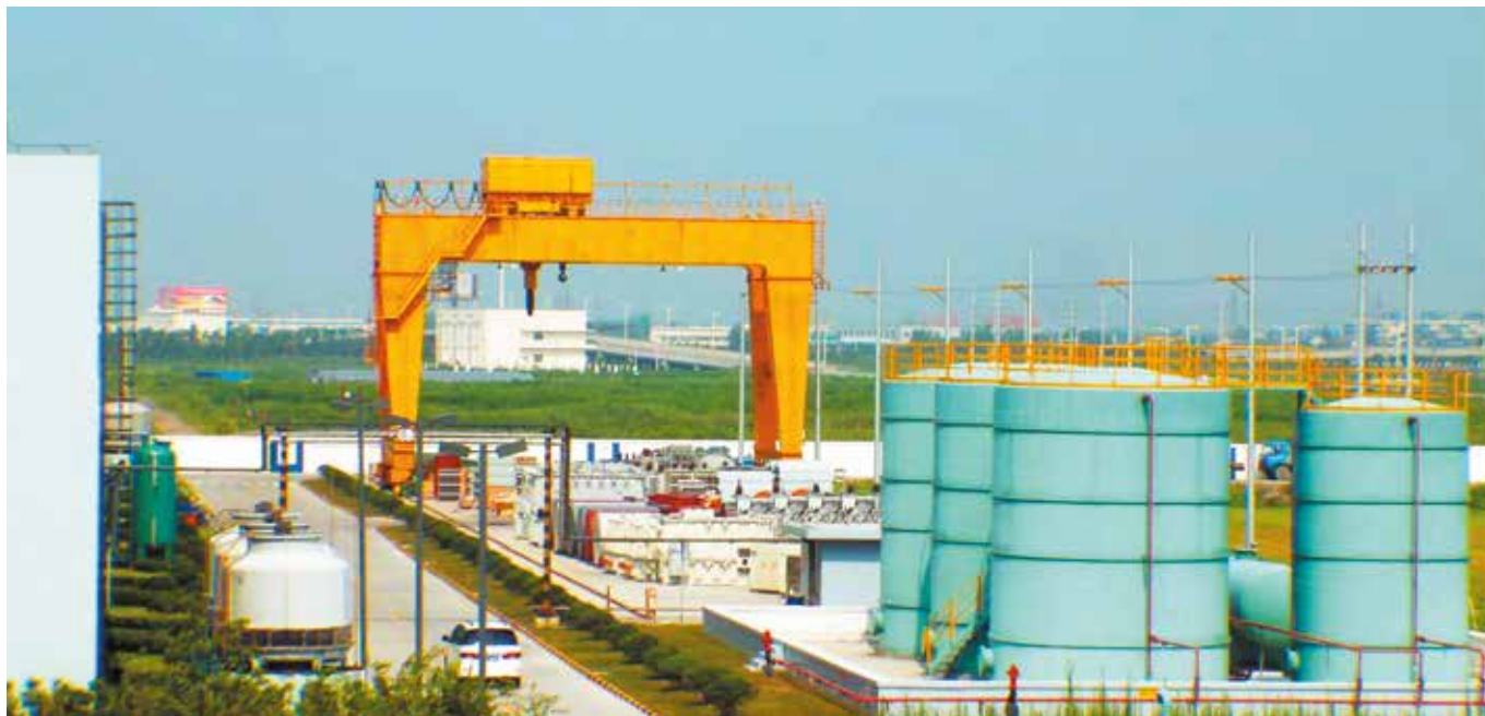
Система хранения и обработки масла ёмкостью 700 т
