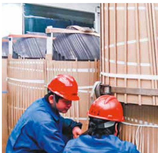
Сборка активной части трансформатора
