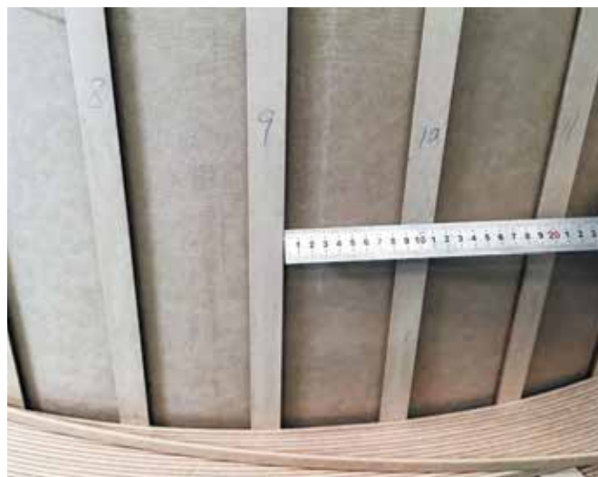
После приклеивания полос производится коррекция интервалов. Погрешность расстояния интервала между двумя полосами не должна превышать 2 мм
