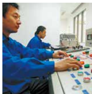
Экспериментальная станция 110 кВ
