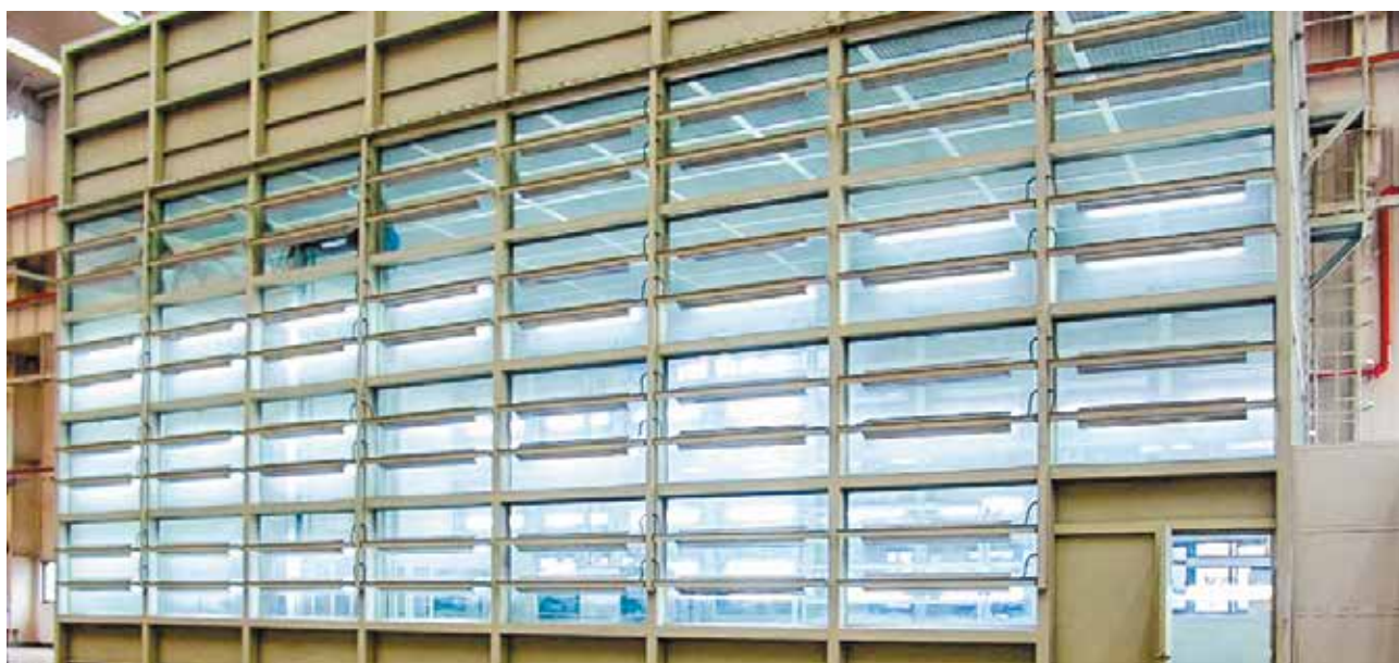
Окрасочная камера размером 16 м с водяной завесой
