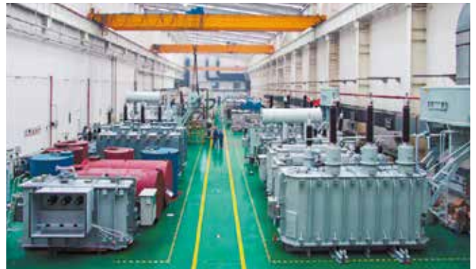
Сборочный цех с избыточным внутренним давлением и кондиционированием помещения
